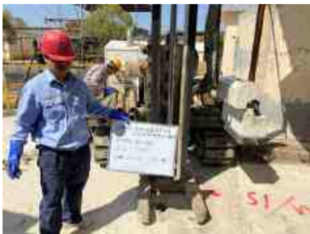
Powerprobe 双套管连续取样
