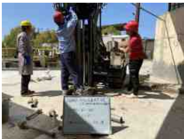
powerProbe 中空直推式钻孔
